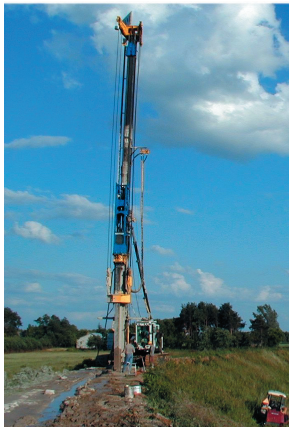
Rys. 1. Palownica w czasie pracy na wale przeciwpowodziowym
