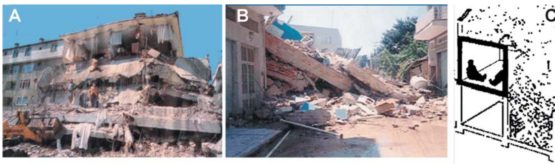
Rys. 3. Gruzowiska typu stok (A) i ruina brzegowa (B) oraz schemat pomieszczenia zasypanego (C) [1]
