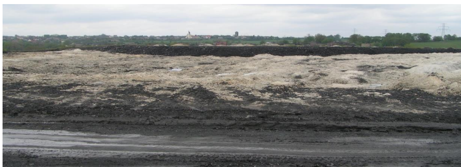
Fig. 4.11. Application of antipyrogens on Waleska dump of “Bolesław Śmiały” Coal Mine (KWK Bolesław Śmiały) [source: own]
